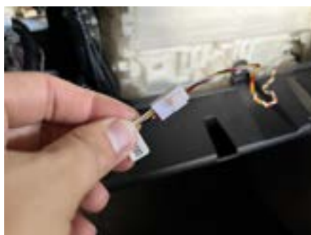
10. 電源取り出しケーブルと製品側の配線を接続し、動作確認後、各部のパーツを戻し作業終了です。
